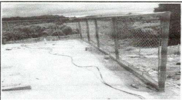
Foto 3: Reparación de muro perimetral de block con tubo hg y malla galvanizada, (soleras intermedias, cimientado de corrido, soleras de humedad, hiladas de block, tubos y columnas)
