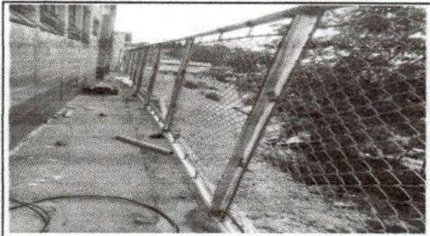
Foto 2: Reparación de muro perimetral de block con tubo hg y malla galvanizada, (soleras intermedias, cimientado de corrido, soleras de humedad, hiladas de block, tubos y columnas)
