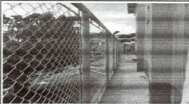
Foto 1: Reparación de muro perimetral de block con tubo hg y malla galvanizada, (soleras intermedias, cimientado de corrido, soleras de humedad, hiladas de block, tubos y columnas)
